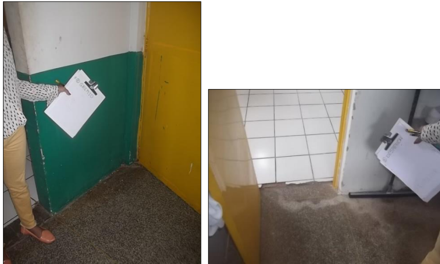
Figura 43: Piso granilite manchado
