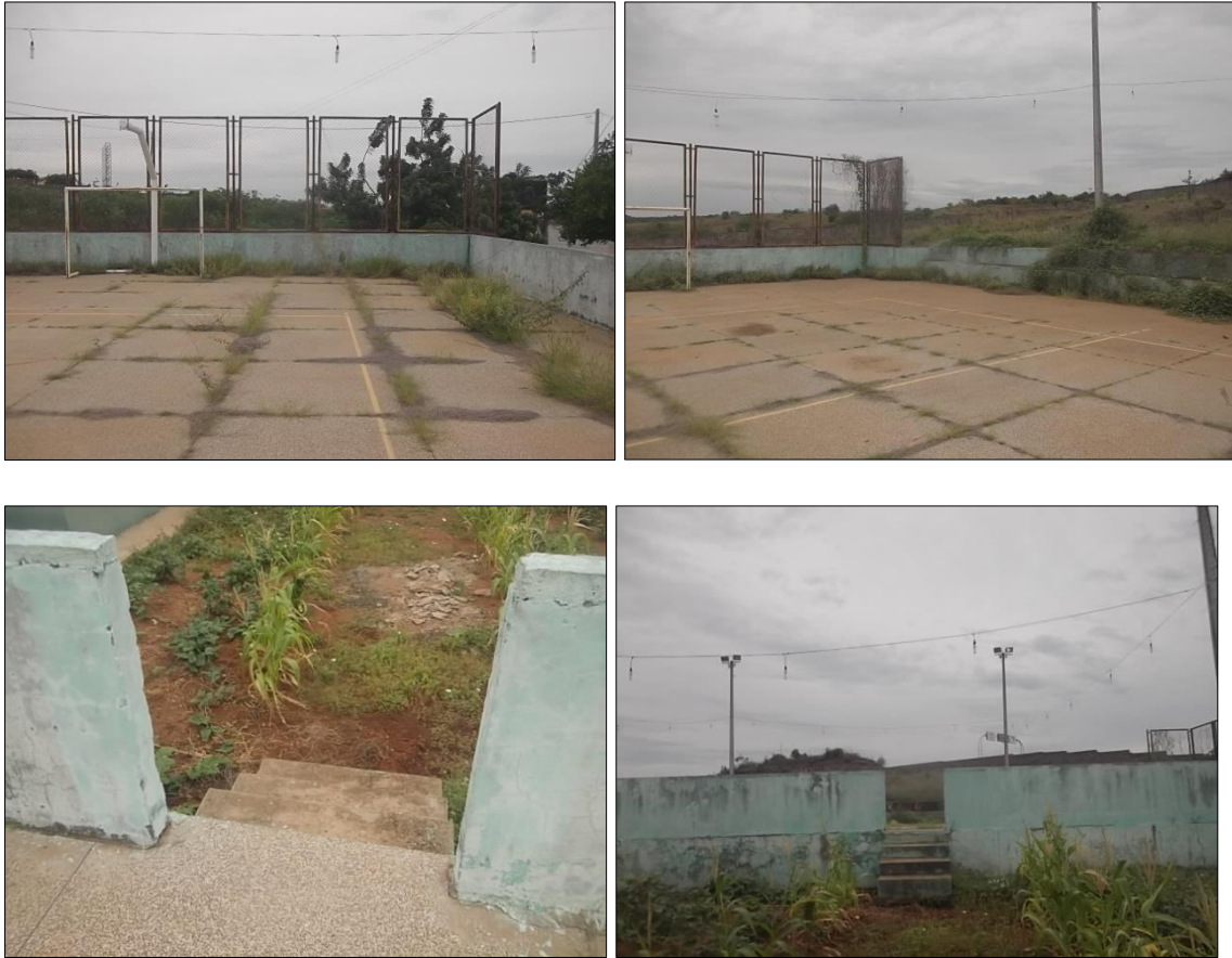
Figura 45: Piso danificado e com vegetação
