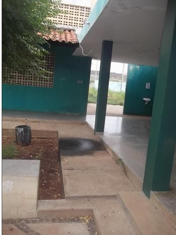
Figura 27: Falta de projeto de Drenagem
