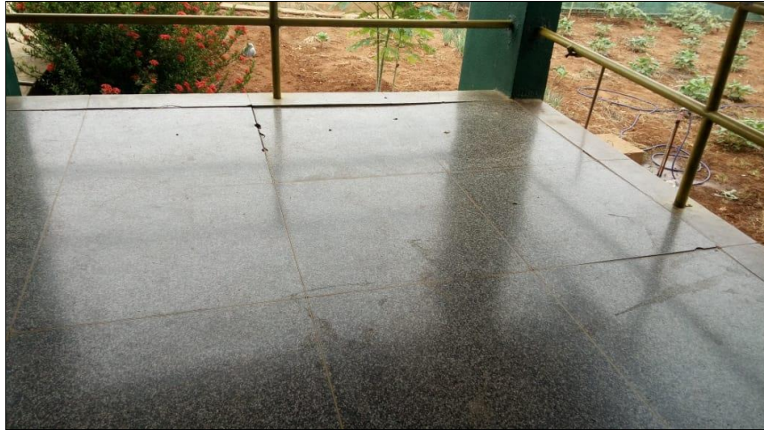
Figura 42: Recalque no piso granilite
