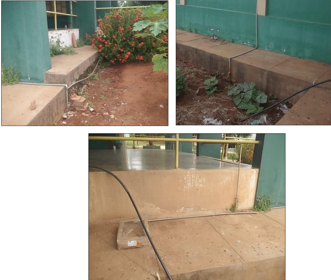
Figura 22: Encanação hidráulica exposta
