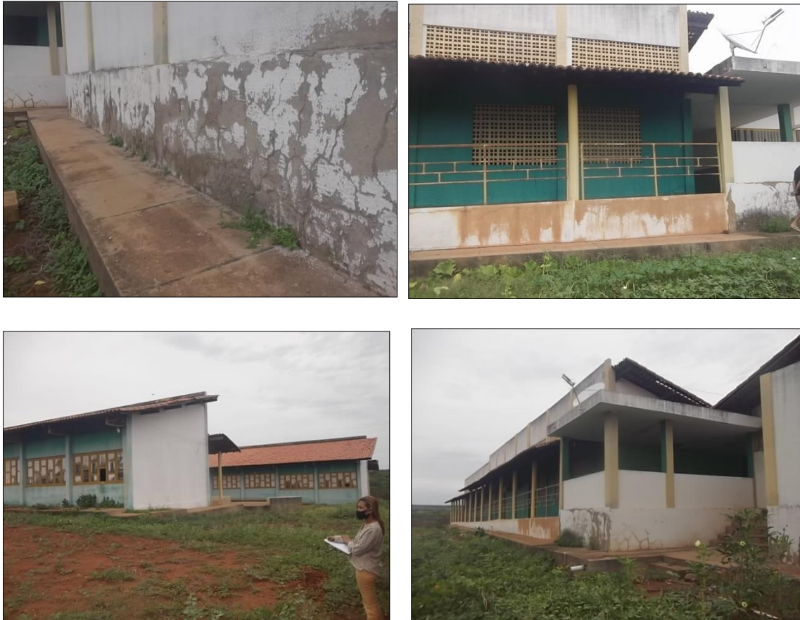
Figura 52: Deslocamento e paredes manchadas
