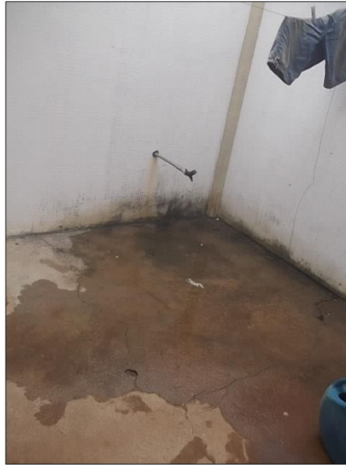
Figura 26: Vazamento no ramal
