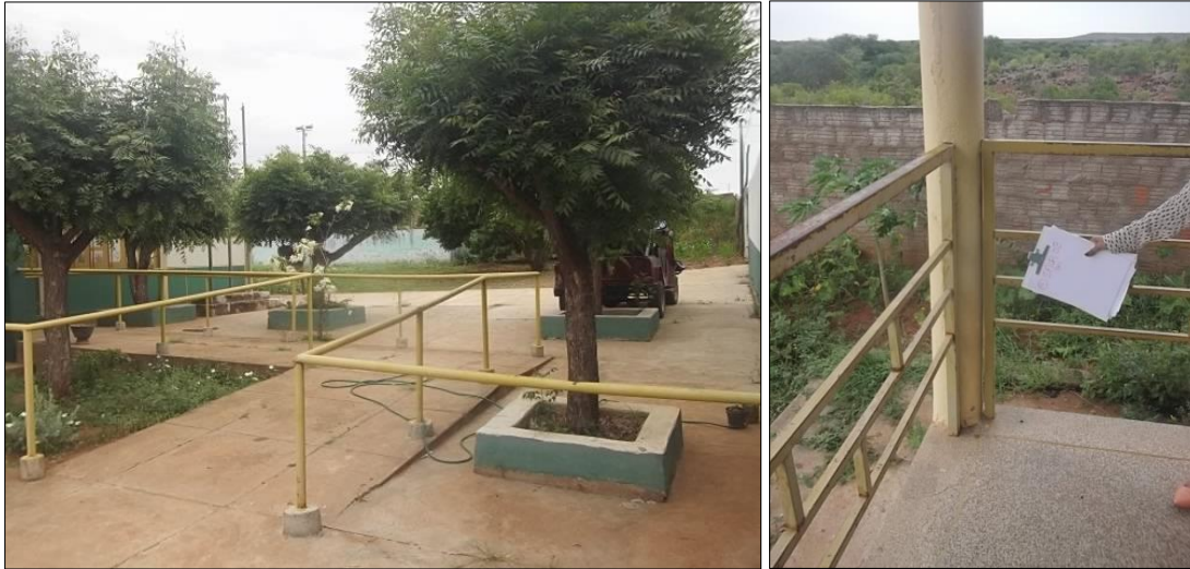
Figura 46: Rampa de acessibilidade suja e sem sinalização, guarda corpo enferrujado
