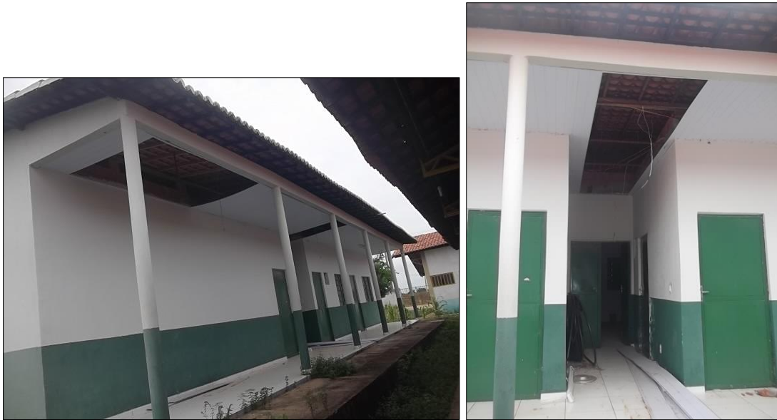
Figura 41: Forro de PVC danificado
