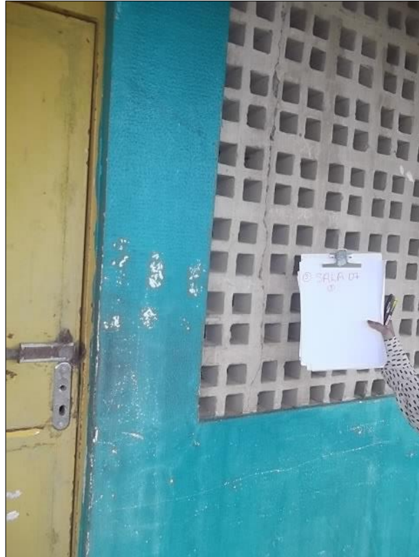
Figura 47: Combogó quebrado e perca de privacidade
