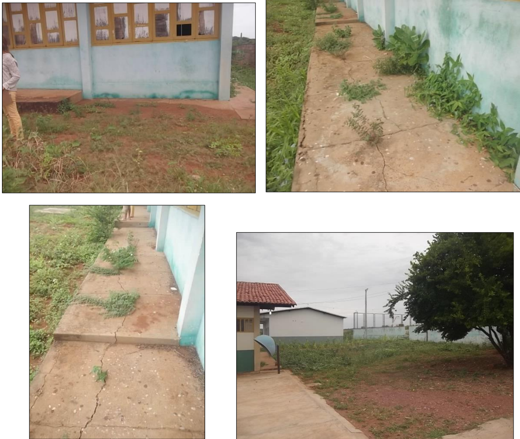
Figura 44: Calçada danificada, enterrada e com vegetação
