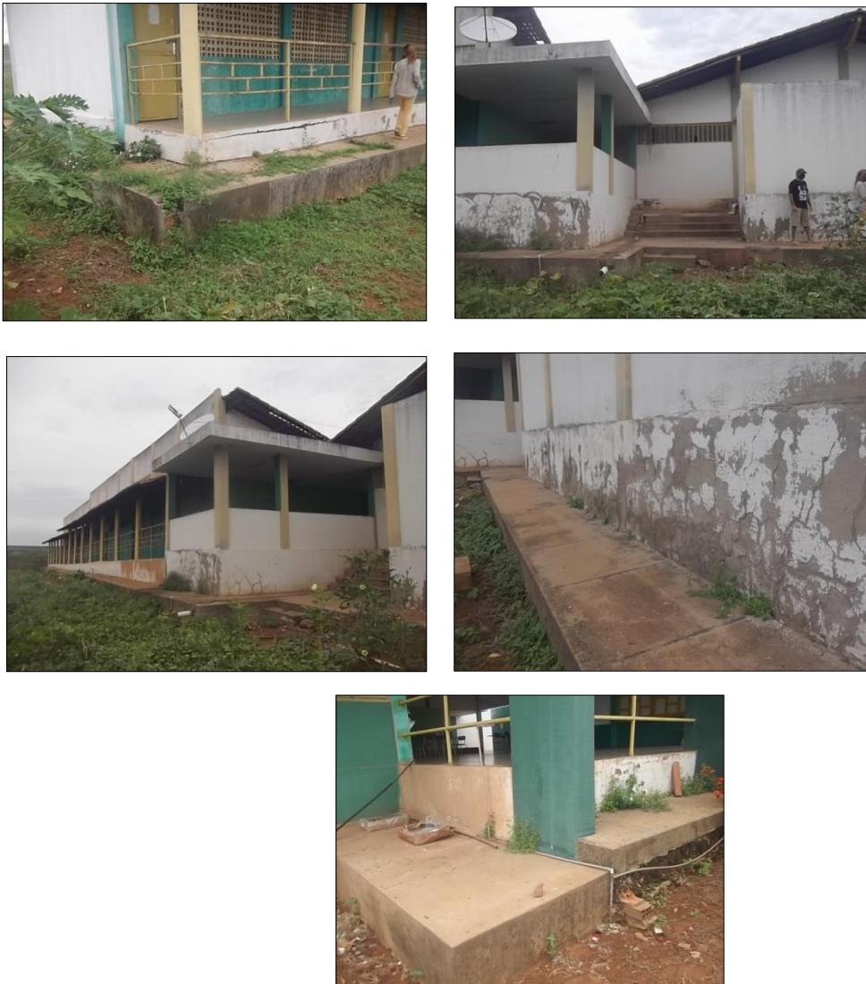
Figura 15: Baldrame com Recalque
